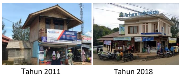
Gambar XIV. Perubahan Tampak Bangunan Sumber: Hasil Survei, 2023.
